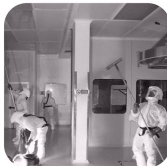
**AMO - Décontamination et démantèlement du système de traitement de l'air, de dépoussiéreurs, d'équipements de production et remise à blanc des salles propres pour un industriel pharmaceutique**
